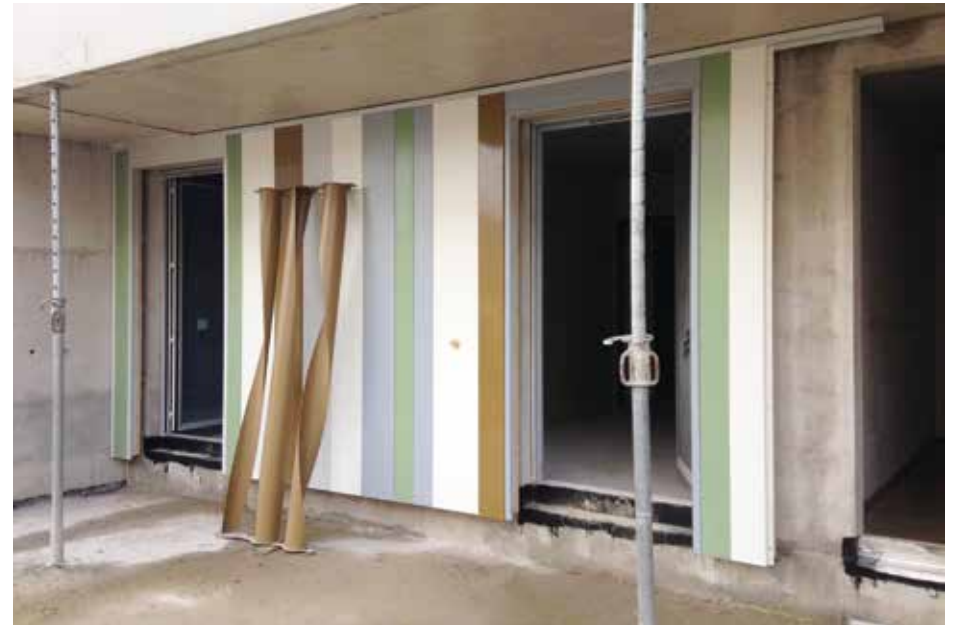
Photographies de chantier
